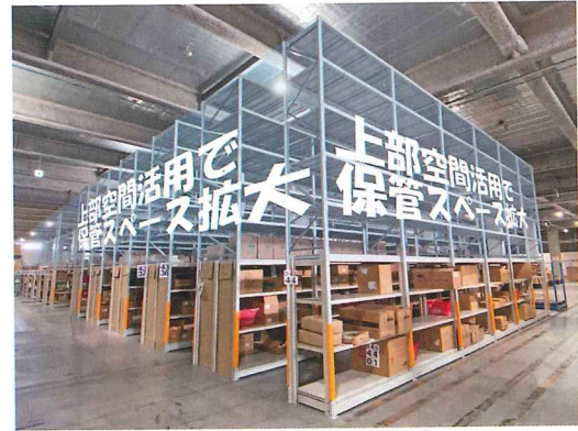
タナ TsumU™ (施工後、工期1日)
